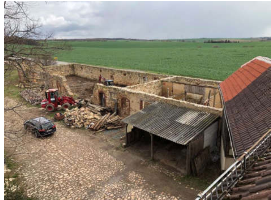
Der wilde Aufwuchs ist beräumt und die Mauerkrone gesichert
